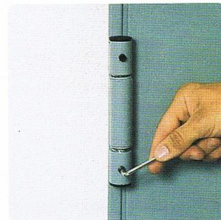
Cerniera portante per le porte **REI** dotata di viti per la registrazione verticale e sfere reggispinta.
